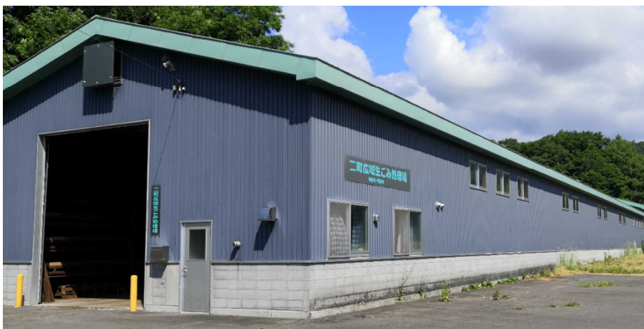
和寒町東和にある二町広域生ごみ処理場
