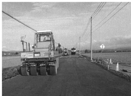
▲昨年度実施した舗装工事の様子
