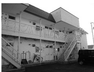
▲改修予定の単身勤労者住宅
