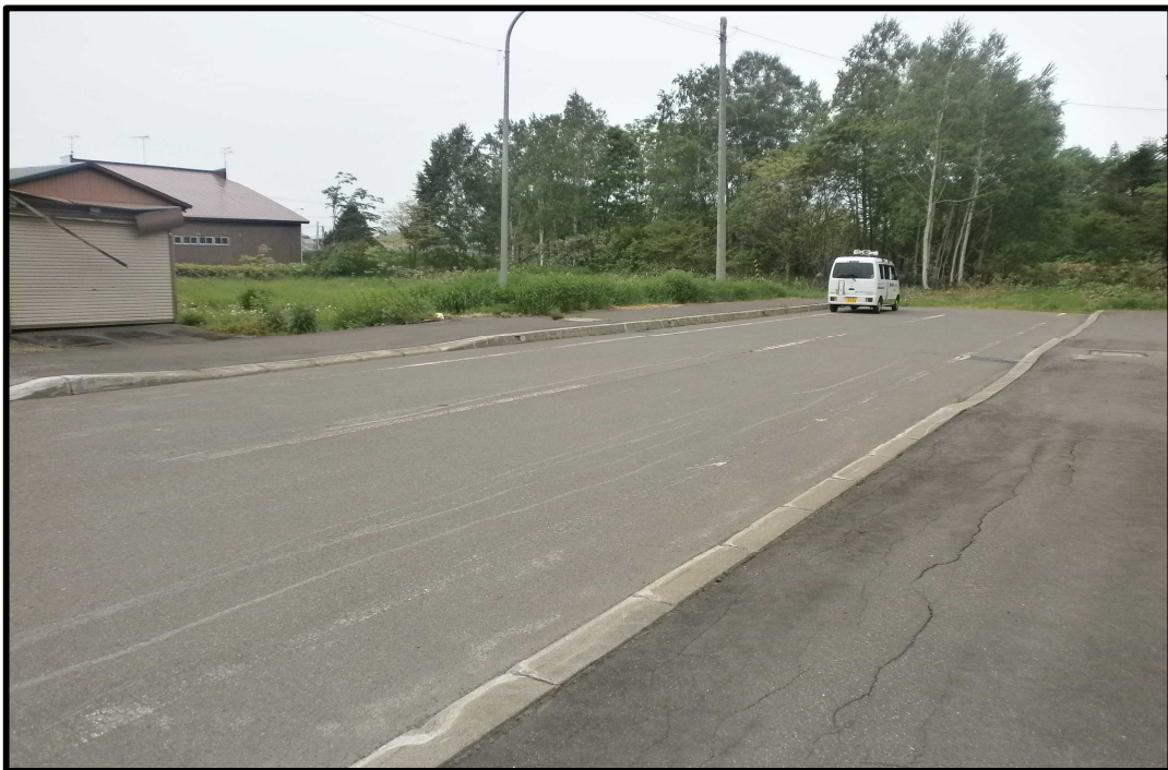
土地周辺写真（土地に面した道路）
