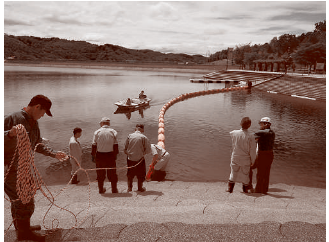
油漏れ防止フェンスを桜岡湖に設置
