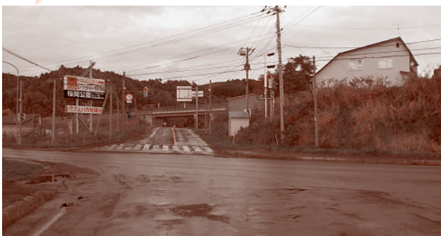
坂道の改良がされる40号線交差点
