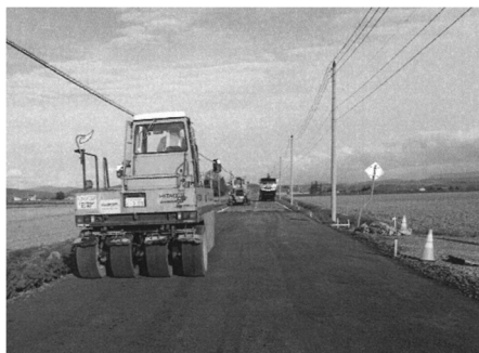
▲昨年度実施した舗装工事の様子
