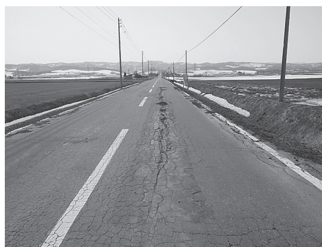
舗装補修前の写真
