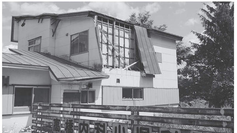
損傷が進む空き家
