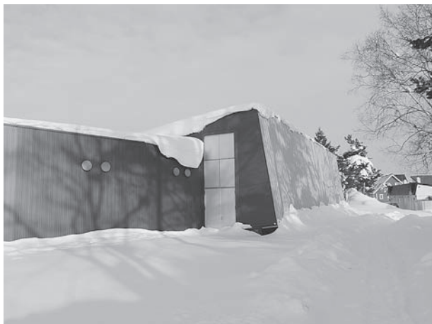
結露対策が望まれる絵本の館搬入口
