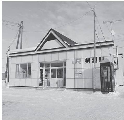
外壁補修された剣淵駅舎
