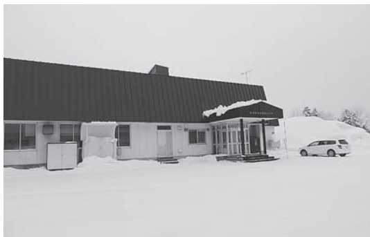
内部改修した給食センター
