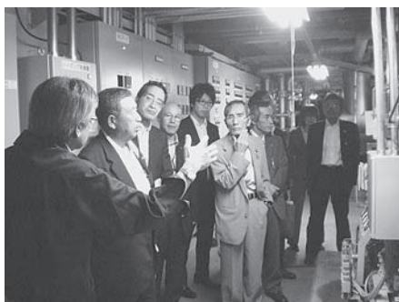
ヒートポンプ視察の様子
