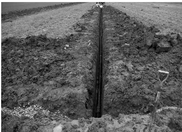
暗渠工事施工状況
