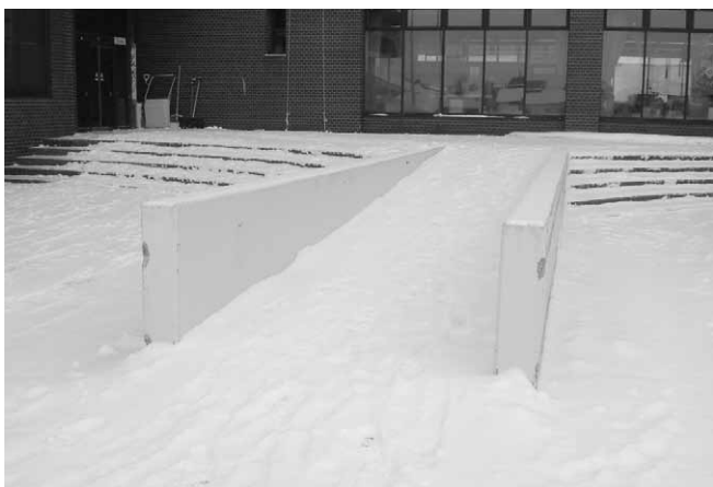
庁舎前スロープ
