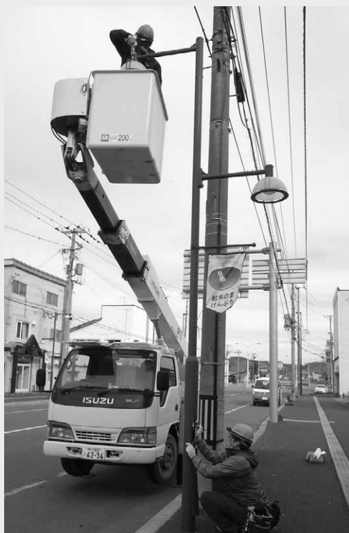
街路灯LED取替え工事
