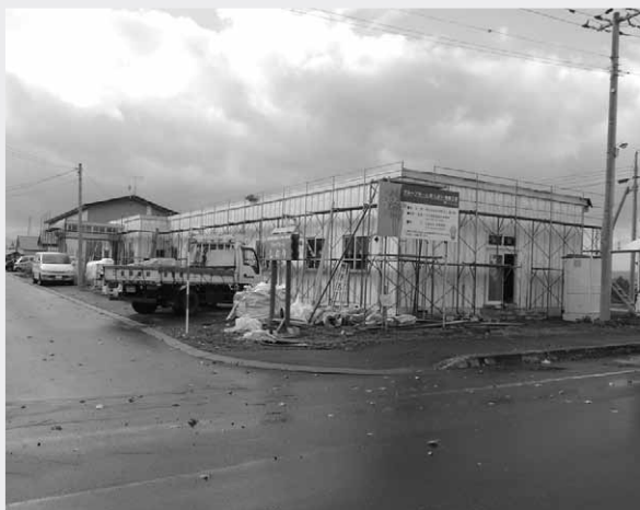
グループホーム葉の増設工事
