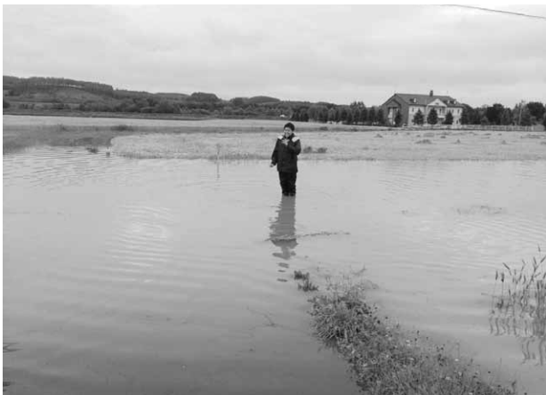
町道が40cm以上冠水 奥の建物が下水道処理場
