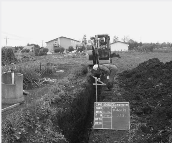
水道施設工事中(仲町町道5線)
