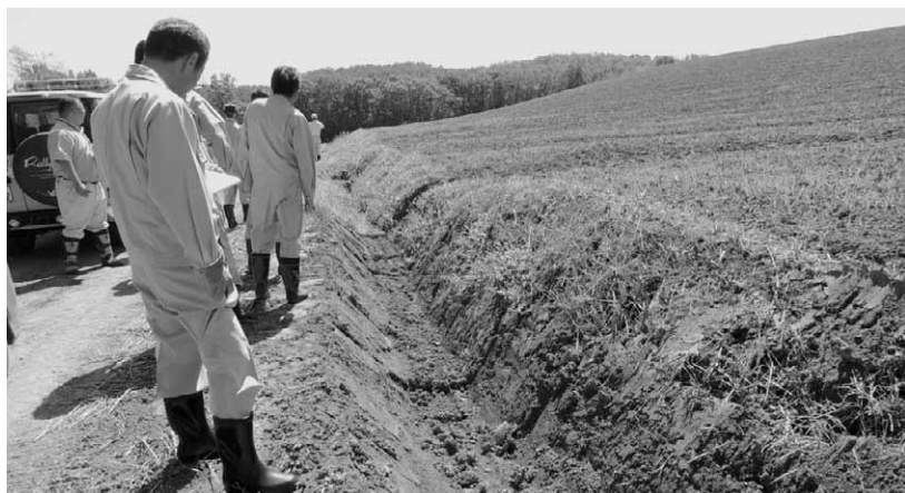
現地土木調査(央南線一南桜町)
