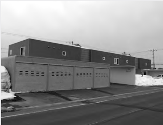
5号棟は東中央団地2号棟と同仕様の予定
