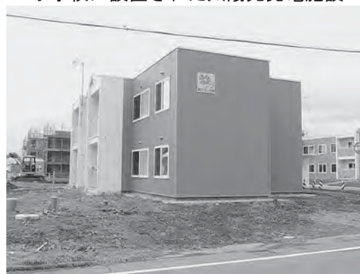
東中央団地3号棟が完成
