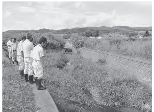
西原町13・14線川合流点の堆積土
