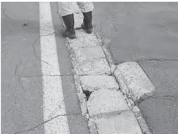
仲町西2丁目コンクリート蓋の破損状況
