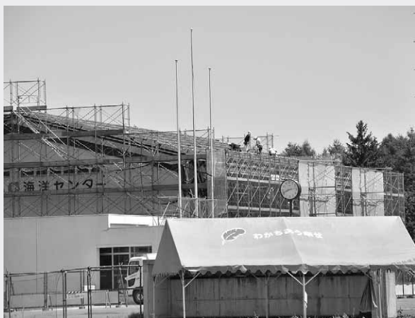
B & G 体育館の屋根改修工事
