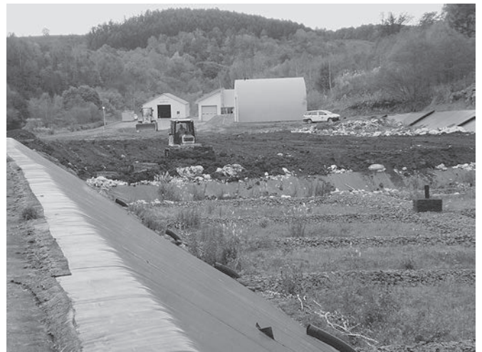
埋立て覆土作業
