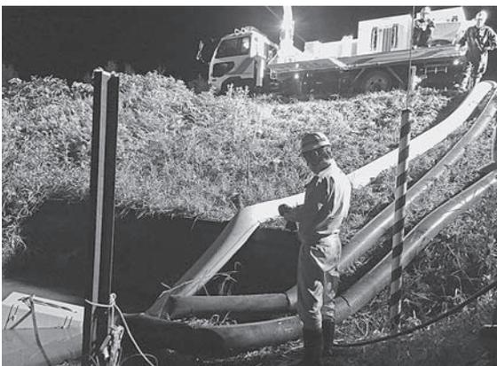
浄化センター付近での開発建設部のポンプ車による汲み上げの様子
