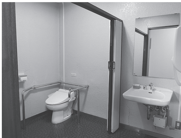
役場1Fの多目的トイレ
