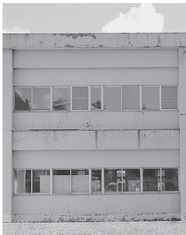
老朽化の進む小学校外壁
