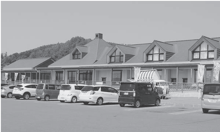
防災拠点として活用が望まれる道の駅
