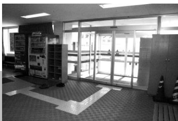
玄関左側にはスロープが新設され、玄関ホールには点字ブロックを設けました。
