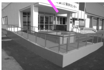
玄関左側にはスロープが新設され、玄関ホールには点字ブロックを設けました。
