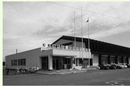
▲改修工事されるB & G体育館
