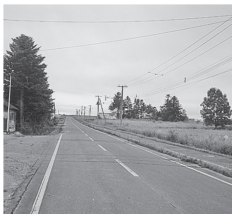
早期に補修が望まれる町道
