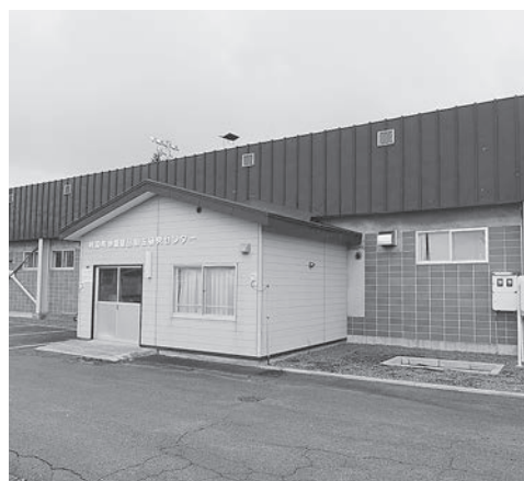
備品更新が望まれる加工センター
