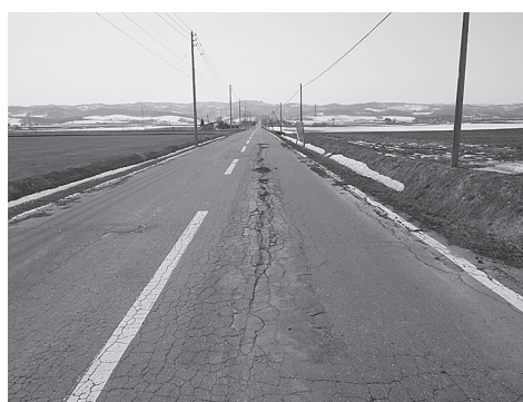
舗装補修前の写真
