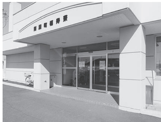
スロープのない福寿寮の玄関
