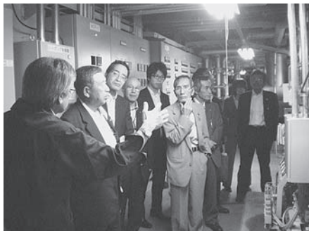
ヒートポンプ視察の様子
